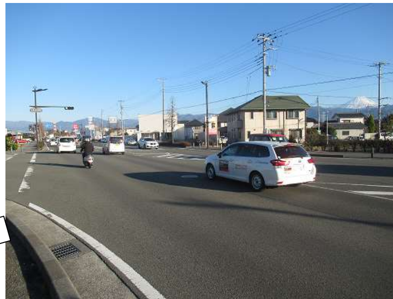
①道路近傍に電柱があり災害時に倒壊する恐れあり
