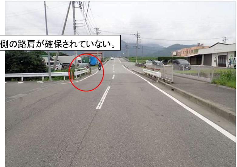
① 道路状況
