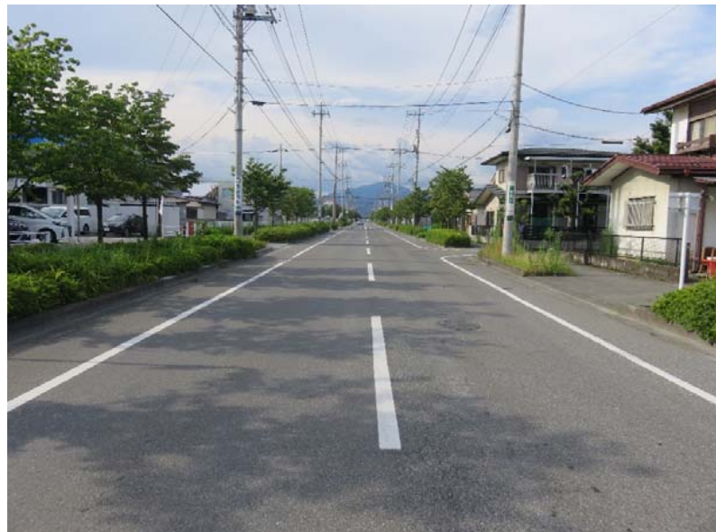
【写真①】 電線、電柱の状況
