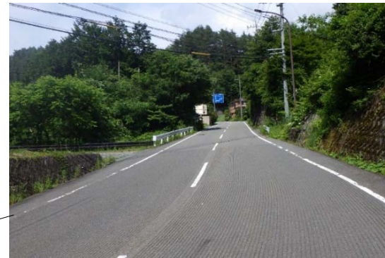
保全対象:国道139号
