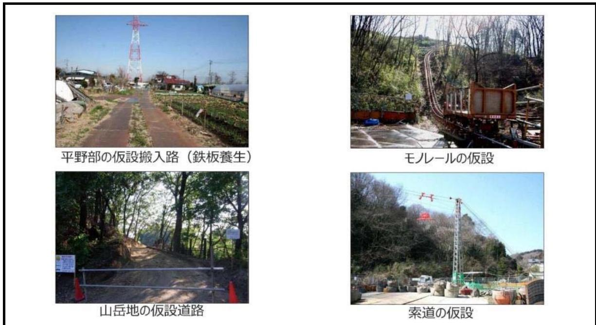
図 1.3.3-14 工事状況の例 (仮設工事・資機材の運搬)
