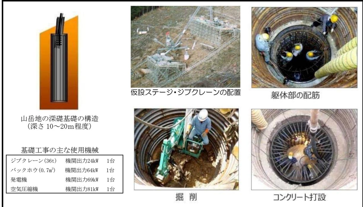
図 1. 3. 3-15 工事状況の例（基礎工事）
