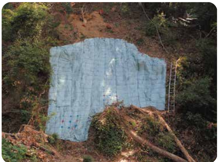
植生マット設置の様子
