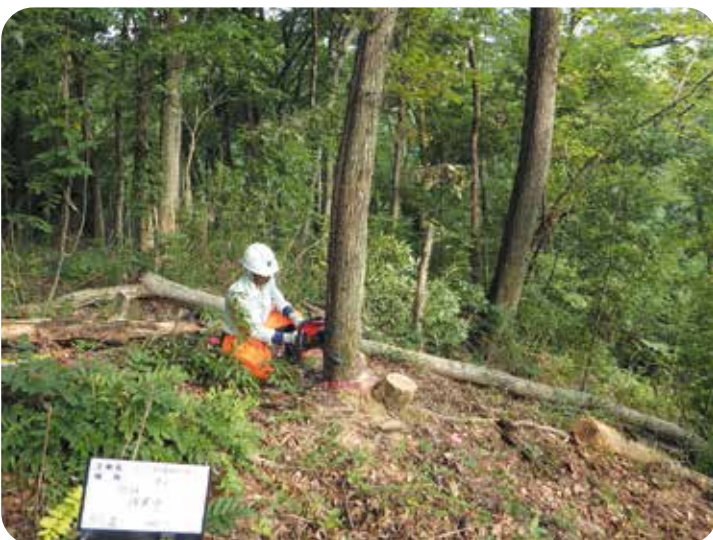
樹木の伐採状況
