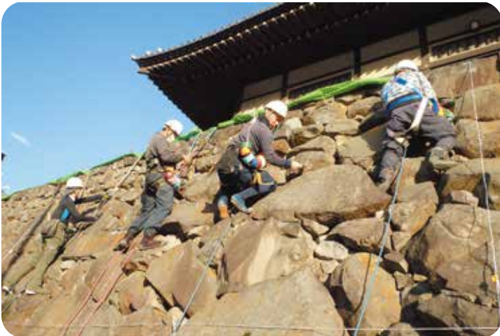
点検作業状況
