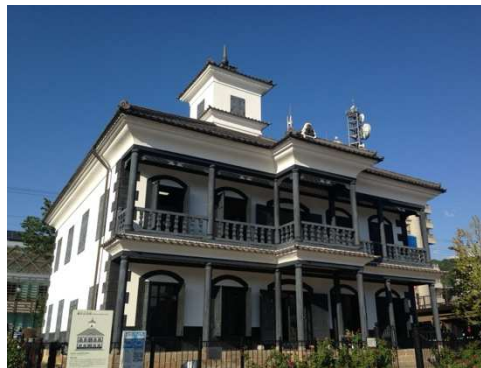
図 27 現存する擬洋風建築である甲府市藤村記念館（重要文化財）
