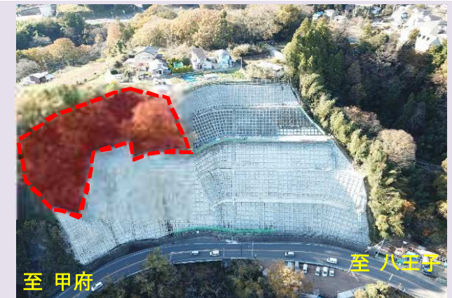
③ さがみはらしみどりよしの 相模原市緑区吉野 斜面崩落防止対策法面工（法砕工）
