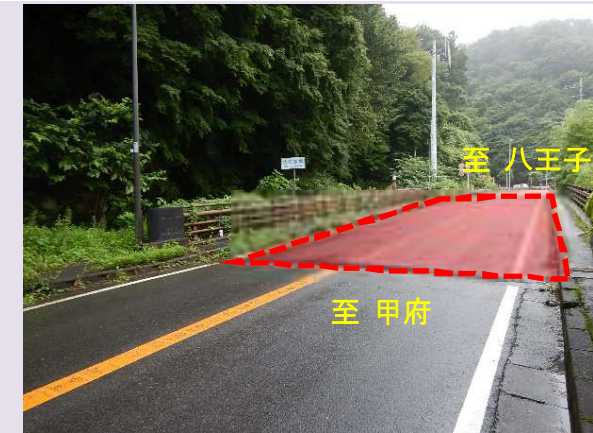
③ 大垂水橋 【橋梁補修】主桁補修、床版補修等
