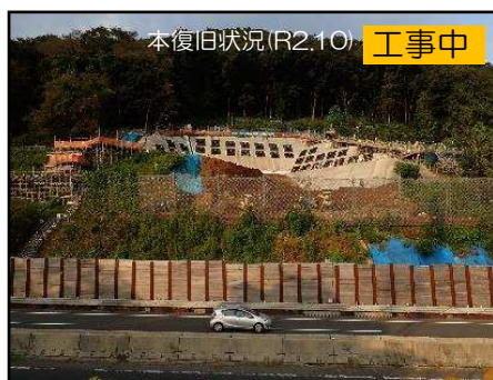
【台風19号 のり面被災箇所復旧事業】
