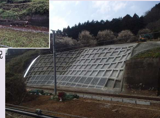
③吹付格子砕工・排水設備整備
