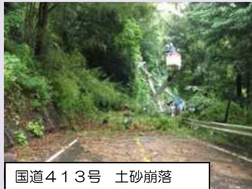
災害防除工事
