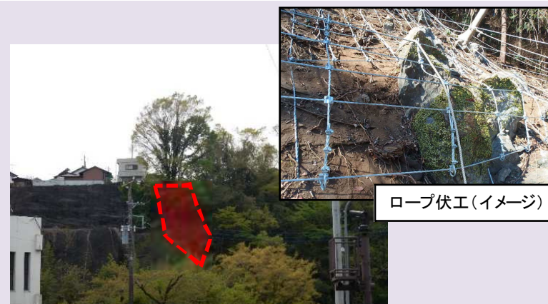
② さがみはらしみどりよしの 相模原市緑区吉野 斜面崩落防止対策法面工（モルタル吹付+ロープ伏工）
