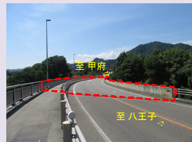
③ つるかわ 鶴川橋 【橋梁補修】主桁補修、伸縮装置補修等
