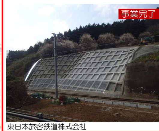
【台風19号応急復旧その他工事】
