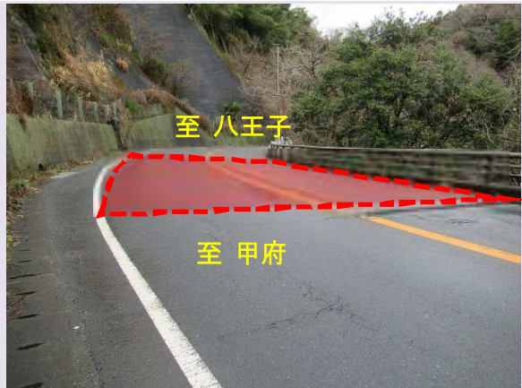
① 第2棧道橋 【橋梁補修】主桁補修、支承補修等
