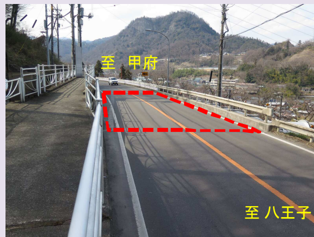
② よこお 横尾橋 【橋梁補修】伸縮装置補修
