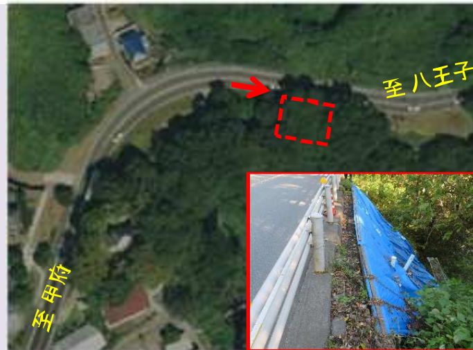
② 山梨県上野原市四方津地先 【防災対策】場所打法枠工等
