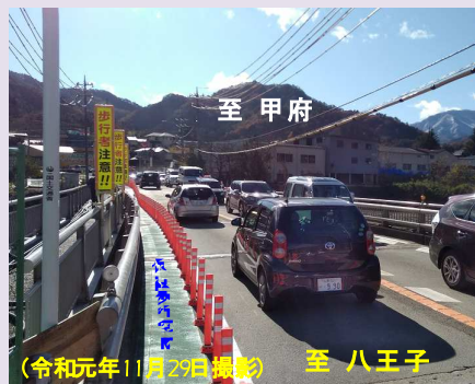
【応急復旧状況】
