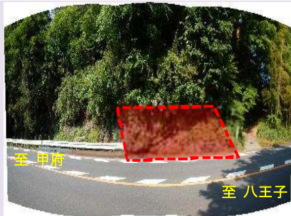
① さがみはらしみどりおぶち 相模原市緑区小淵 斜面崩落防止対策法面工（コンクリート吹付）
