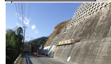
国道413号 工事中
