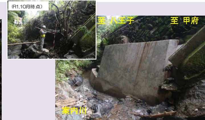
はちおうじしみなみあさかわまち ③ 八王子市南浅川町 根継工による復旧完了
