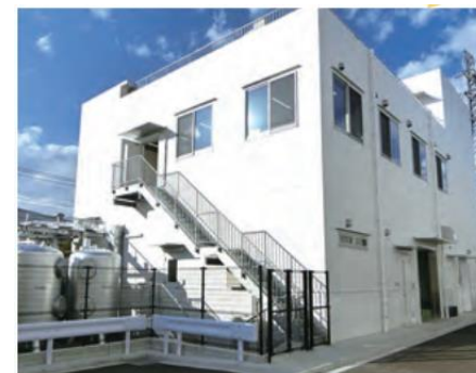
新エネルギー棟
