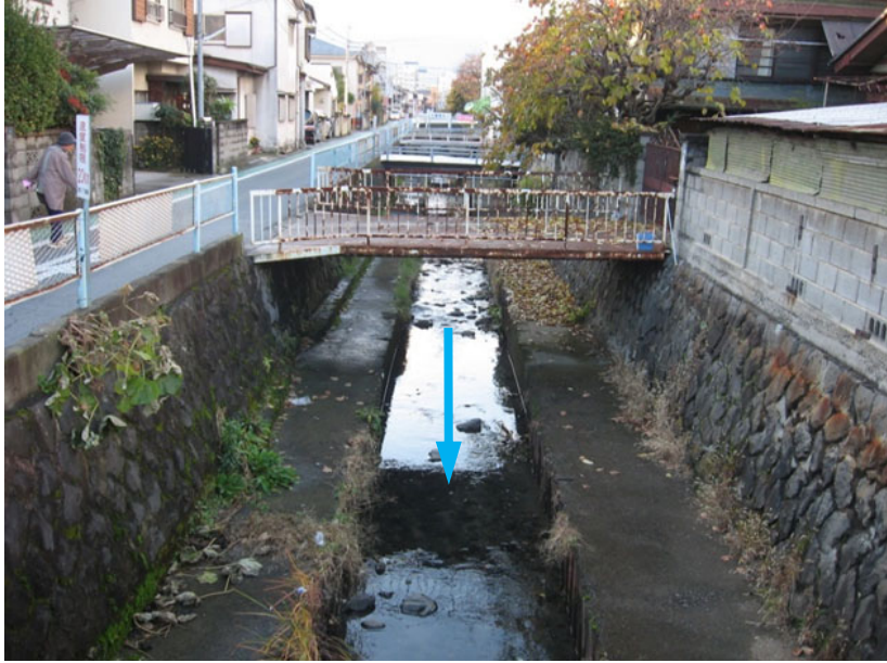
③ 省路橋上流付近
