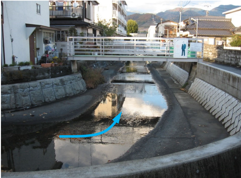
⑤ 開運橋上流屈曲部
