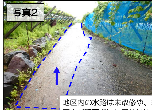
地区内の水路は未改修や、未整備で雨水が路面を流れ農地に入るとなると湿害の要因となっている。
