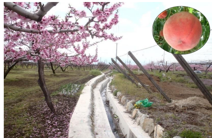
完成後 水路改修による排水改良や表土の流出防止により、営農条件が改善され、農作物の品質が向上した。 既設の石は土留めに利用するなど、景観にも配慮した整備が行われている。
