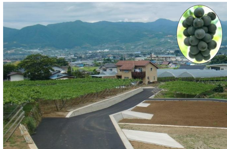
完成後 区画整理により農作業効率が向上し、収益性の高い農業経営が可能となった。
