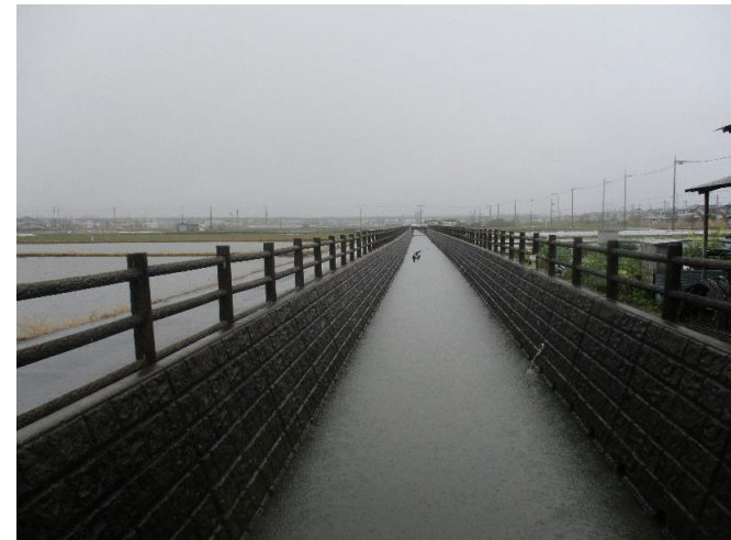
④ 整備後： 排水路の排水状況
