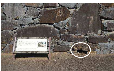
暗渠（本丸地区）
