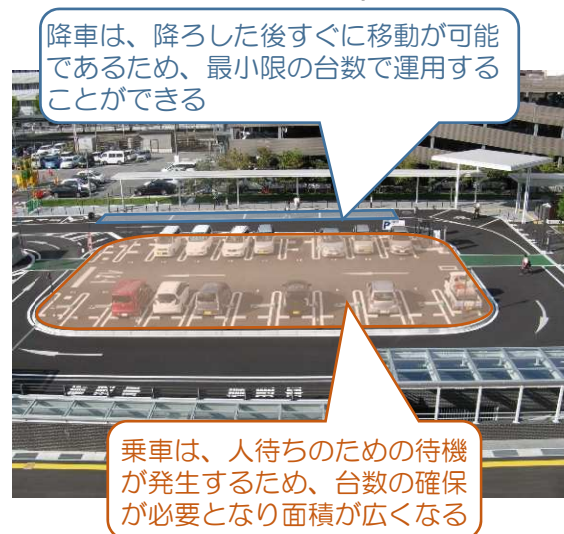
短時間駐車場の事例 (甲府駅南口)
