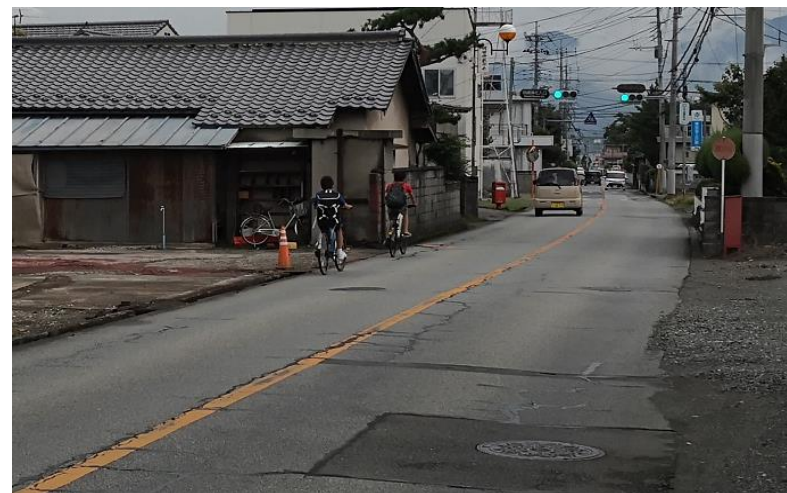
② 現況道路状況
