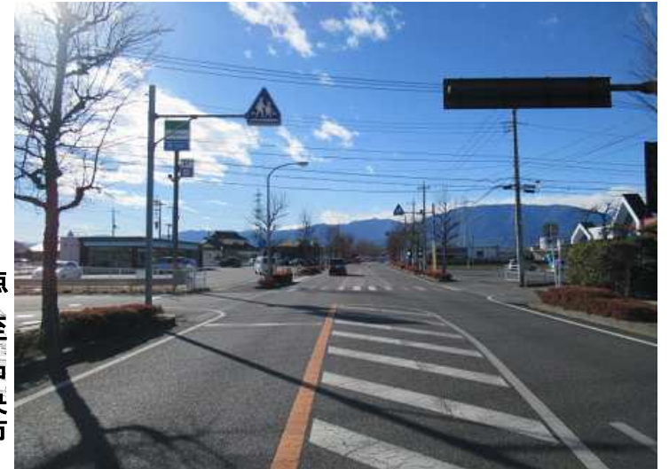
① 現況道路状況
