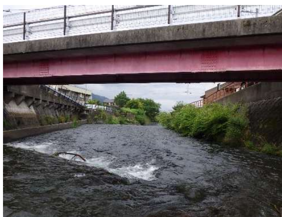
調査地点遠景・下流側（柿林橋）
