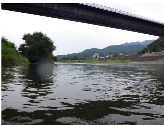
調査地点遠景・上流側
