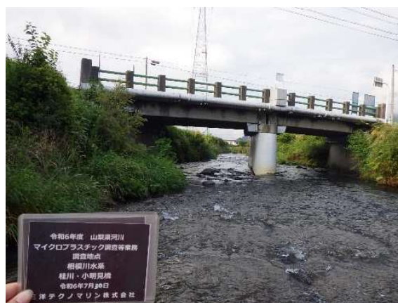
調査地点遠景・下流側（小明見橋）
