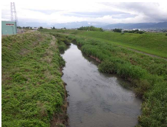
調査地点遠景・上流側
