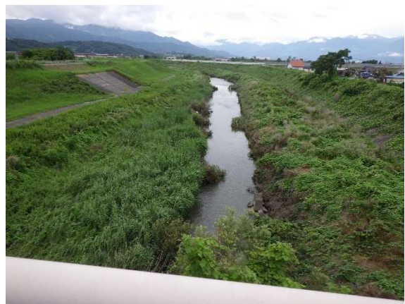
調査地点遠景・下流側
