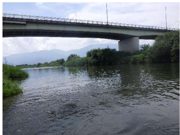
調査地点遠景・下流側（桃林橋）
