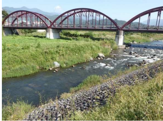
笛吹川上流部:③亀甲橋
