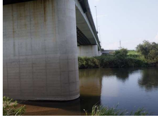
笛吹川下流部:④桃林橋
