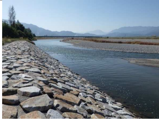
釜無川下流部:②浅原橋
