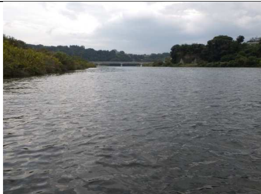
桂川県境部:⑦桂川橋
