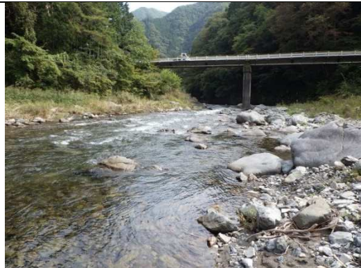
丹波川県境部:⑧下保之瀬橋
