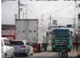
国道411号・勝沼拡幅 改良前
