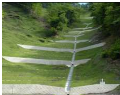
山腹工による崩壊地の復旧状況
