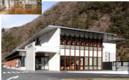
H27 早川町庁舎 木材量 142 m 3 （県産材 141 m 3 ）
