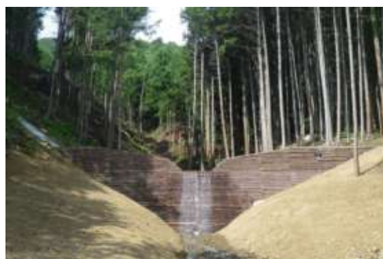
治山ダム設置による土砂流出防止対策
