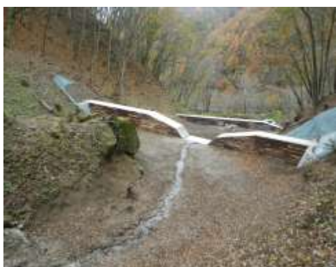
治山ダムの設置
