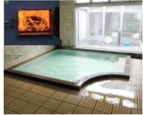
木質バイオマス利用温泉施設
