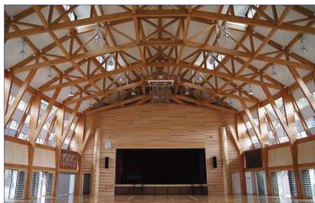
【トラス構造を用いた事例】
