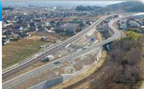
八幡北ランプ側から甲府方面を望む
