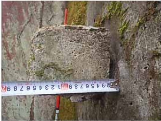
写真1 変位量の計測
