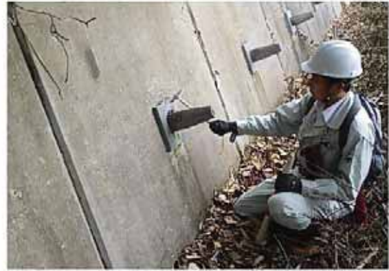
写真2 ハンマーによる打音調査
