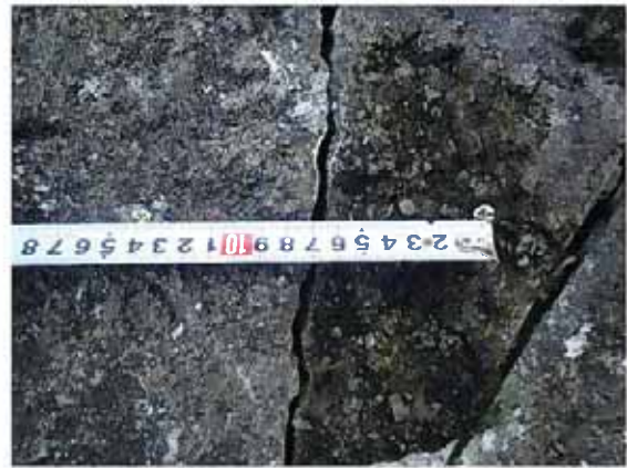
写真4 変位指標（鉾）の設置
