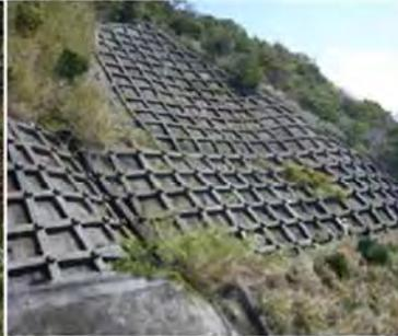
写真：法枠工+アンカー工
