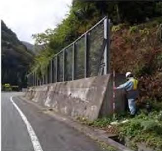
写真：落石防護柵工
