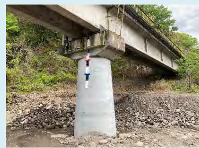
③塩崎・韮崎間 (2023年5月完了)
