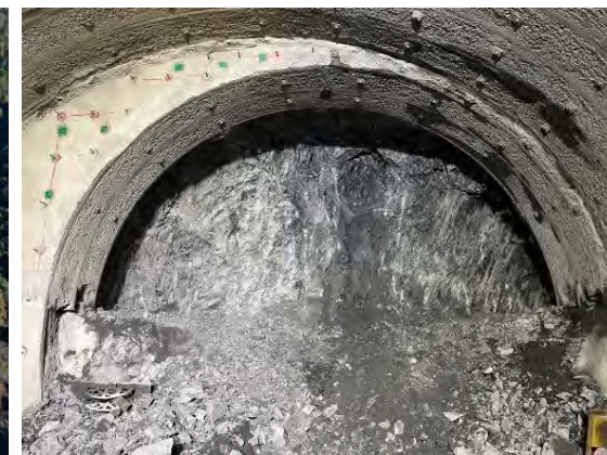
写真：2023年12月 ※掘削進捗：約930m/約2,300m(2023.12)
