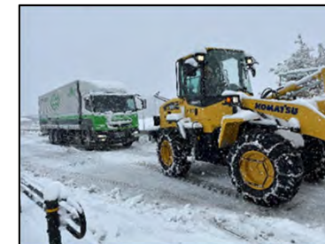
国道20号韮崎市円野町 (スタック発生状況)
