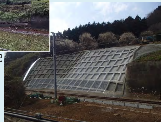
③吹付格子砕工・排水設備整備
