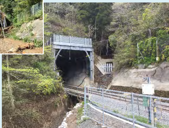
①しゅん濇・土砂止めスクリーン復旧
