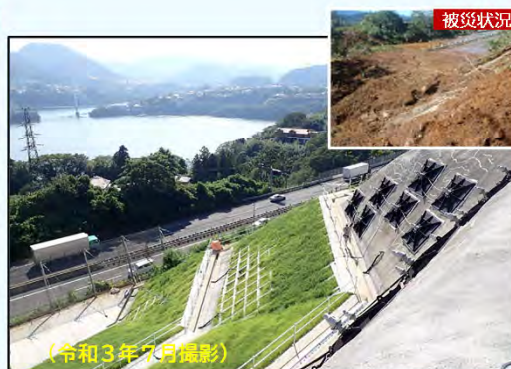
（令和3年7月撮影） 写真：中央自動車道 与瀬地区の復旧作業完了状況
