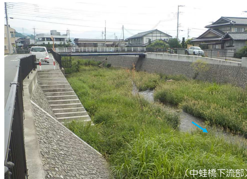
現況 (階段の設置状況)
