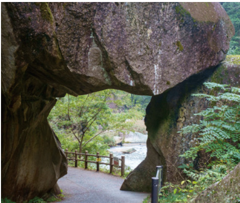
新道開削工事でできた石門
