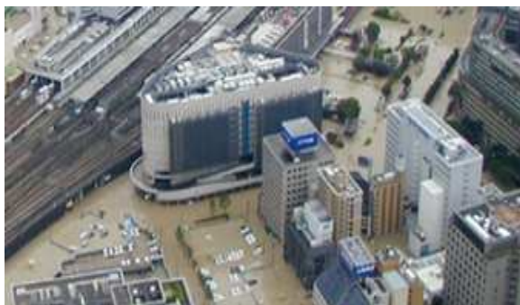
浸水の状況（H15 博多駅）
