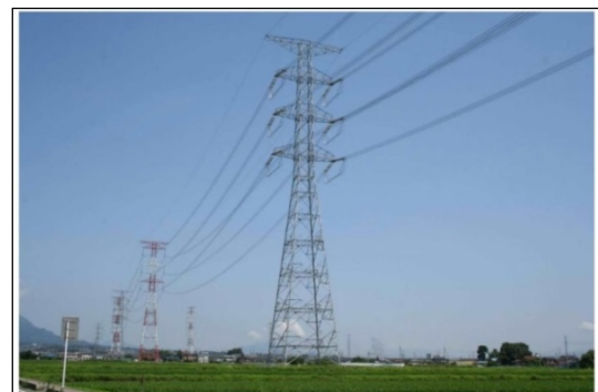
送電線路の完成例
