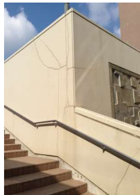
外壁劣化によるひび割れ
