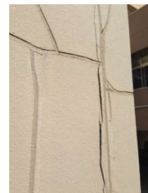
外壁劣化によるひび割れ
