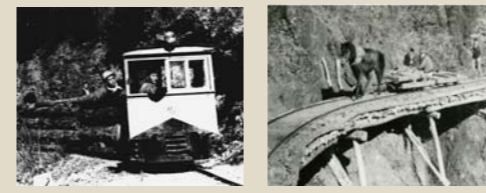
県営稲又新伐事業軌道機関車運材 軌道運材 山梨市（旧三番村）
