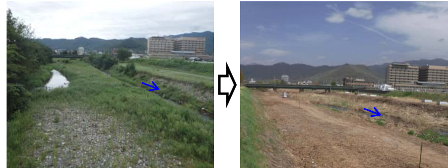
荒川 伐木 L=3,000m A=27,000m 2 (写真は甲府市下飯田一丁目地内 長松寺橋上流)
