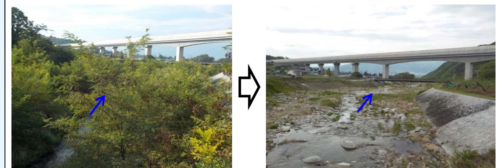
金川 伐木 L=3,270m A=116,800m 2 (写真は笛吹市御坂町上黒駒地内 山梨リニア実験線上流)
