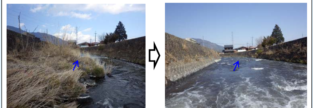
桂川 浚渫 L=720m V=360m 3 (写真は富士吉田市下吉田地内 新焼橋下流)
