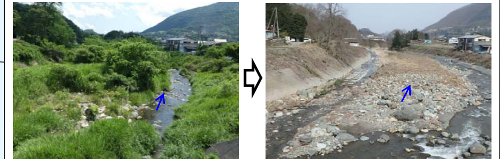
笹子川 伐木 L=400m A=8,000m 2 (写真は大月市初狩町下初狩地内 藤沢橋下流)
