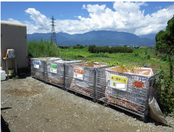
工事現場での分別の様子
