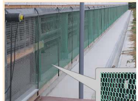
▲防鳥ネットの設置
