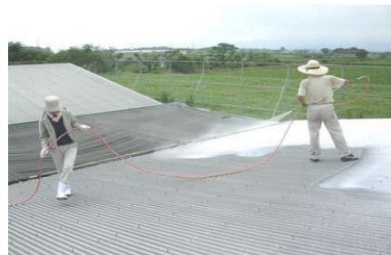
石灰の吹きつけ
