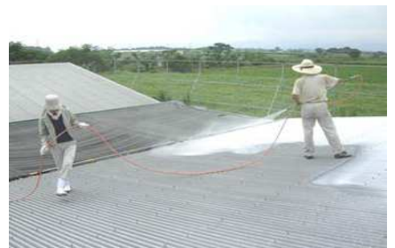
石灰の吹きつけ
