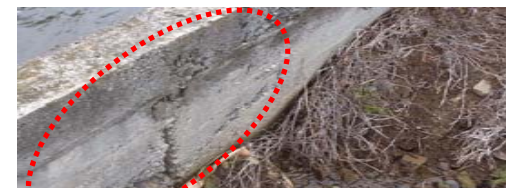
⑤ 水路断面の破損により漏水している「用水路」
