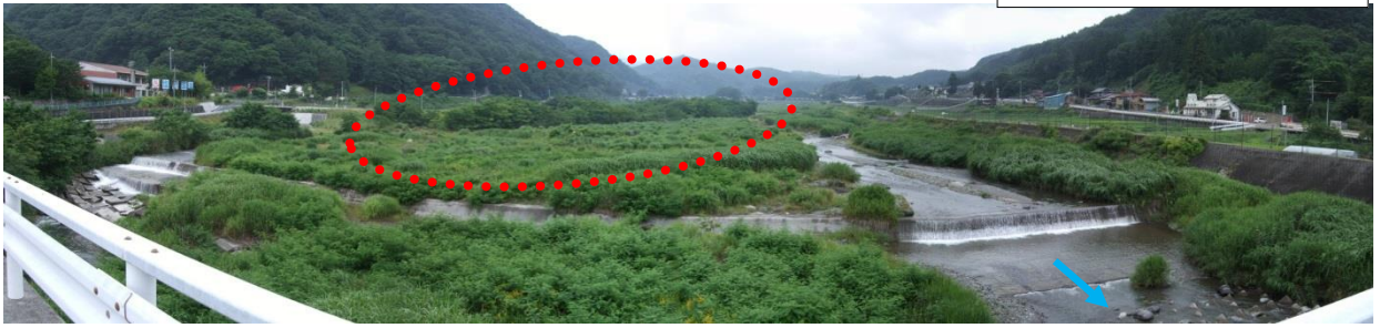
諸水橋から一級河川釜無川上流を望む
