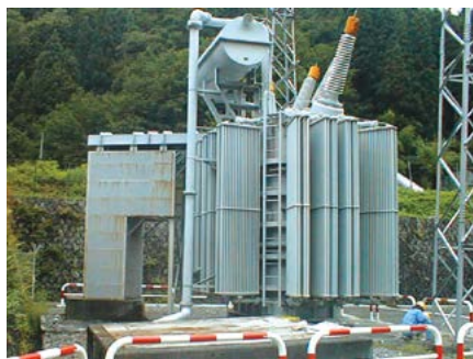
施設外観-改修前
