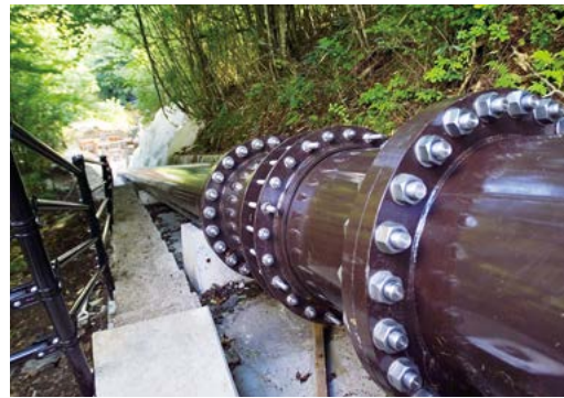
導水路管から琴川第三発電所敷地を見下ろす
