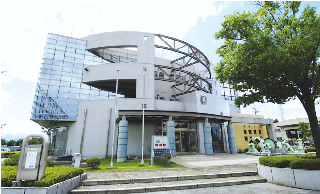
クリーンエネルギーセンター
