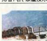
東海道本線鉄橋の流失
