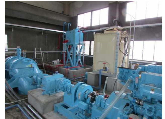
排水ポンプ更新
