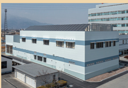
イノベーション支援棟（外観）
