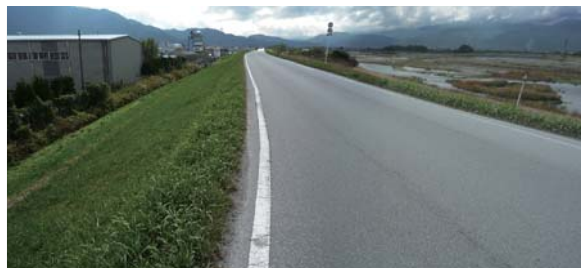
上流荒廃地から流出した土砂の堆積により洪水土砂はん濫被害が起こりやすくなっている釜無川本川の河床上昇の状況
