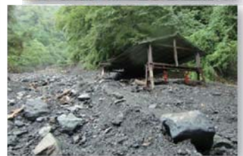
平成23年9月の台風12号により、車約20台、資材運搬用索道小屋が埋没した土石流災害（早川町羽衣）
