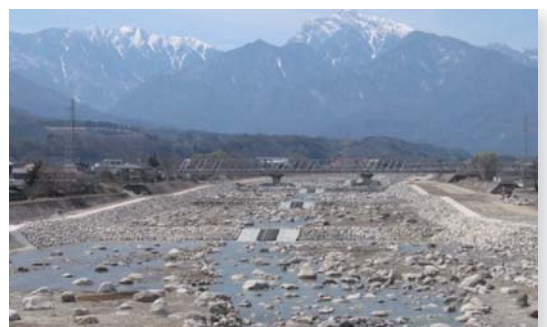
谷出口の河道を安定させ周辺の人家や田畑を土砂災害から直接保全する大武川床固群
