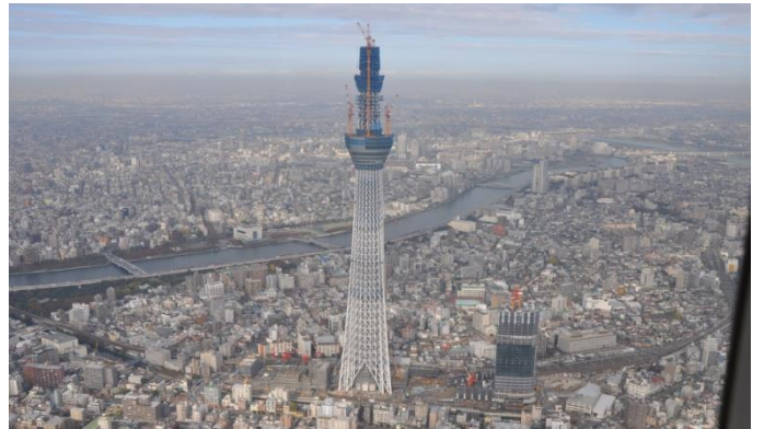
(建設途中の東京スカイツリー)
