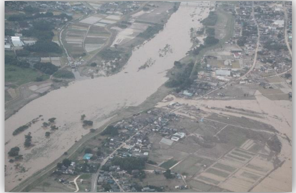
堤防決壊箇所
