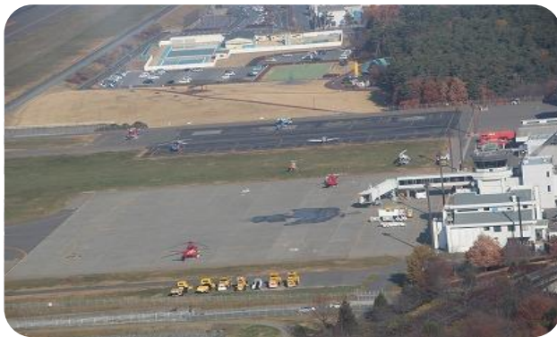
上空からの松本空港
