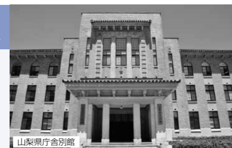
山梨県庁舎別館
