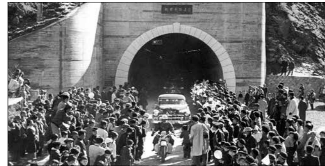
新笹子トンネル開通
