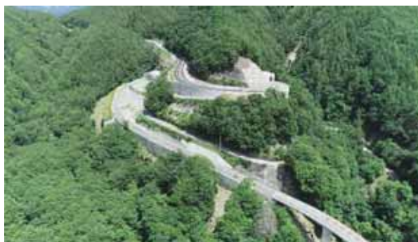
▲国道411号(上萩原Ⅲ期バイパス)
