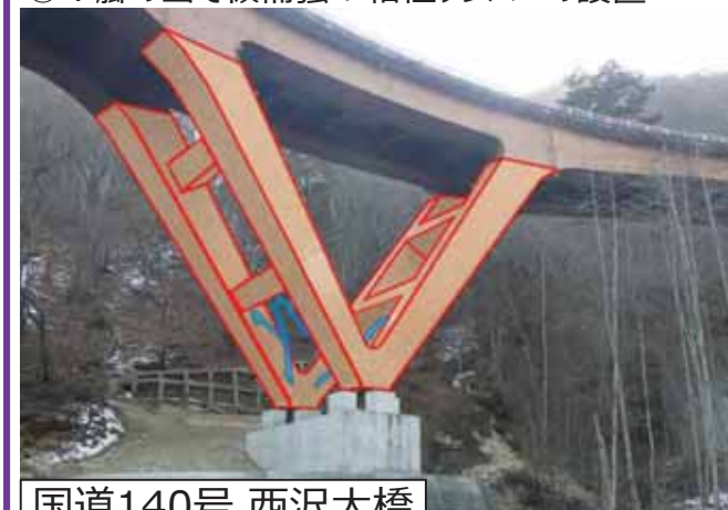
○V脚の当て板補強+粘性ダンパーの設置
