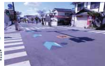
▲モデルルートにおける自転車走行空間整備 (甲府市武田地内)
