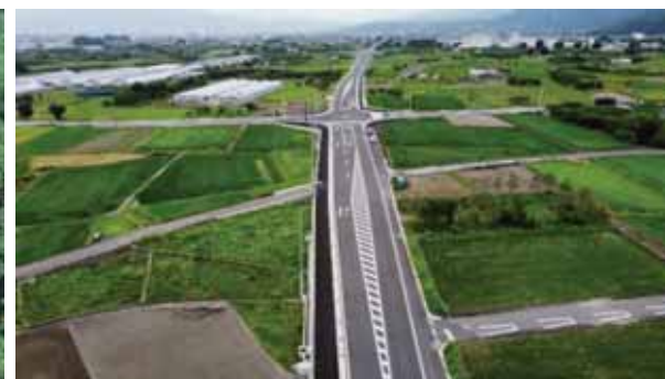
▲(主)韮崎南アルプス中央線(旭有野バイパス)
