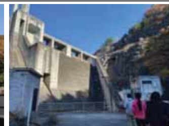
<ダム堤体下でのドローン飛行>
