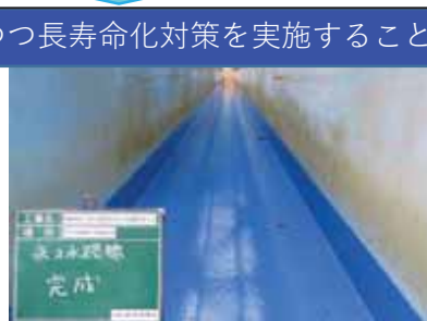
再塗装により錆を防止
