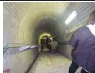
<監査廊の見学>
