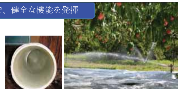
内面被覆による補強を行い安定的な用水供給を確保
