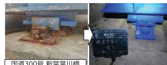
○ 橋桁を支える支承の補修・再塗装
