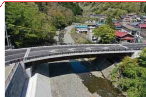
▲国道139号(小菅橋)
