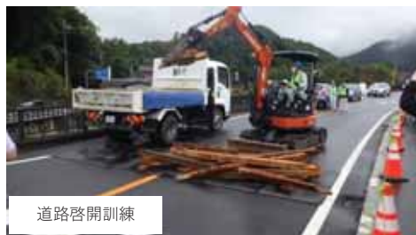
道路啓開訓練
