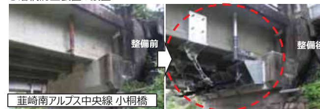
○落橋防止装置の設置
