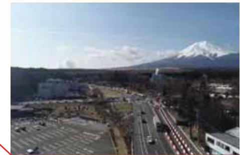
▲国道138号（新屋拡幅）
